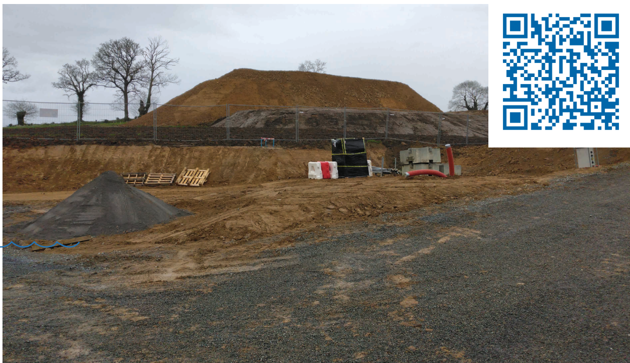
Terrassement 2024 - nouvelle usine d’eau potable Fougère - La Forairie
